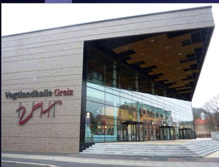
**FREI AUSKRAGENDES VORDACH (12 m) IM EINGANGSBEREICH MIT ABGEHÄNGTER STAHL-GLAS-FASSADE**
